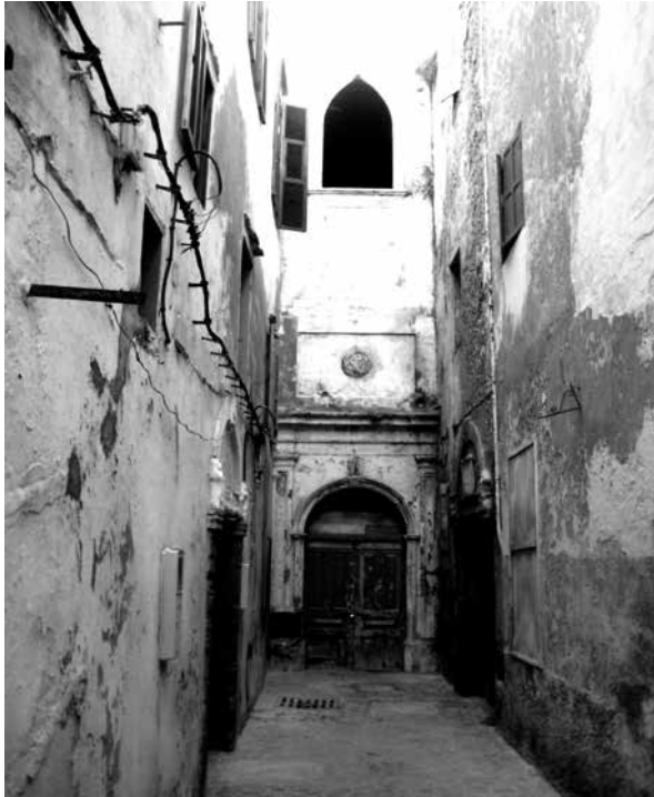
Fig. 3 – Siège du Consulat du Portugal datant du 19ème siècle, à Essaouira, ancienne Mogador (Maroc) ©R. Ragala, 2008
