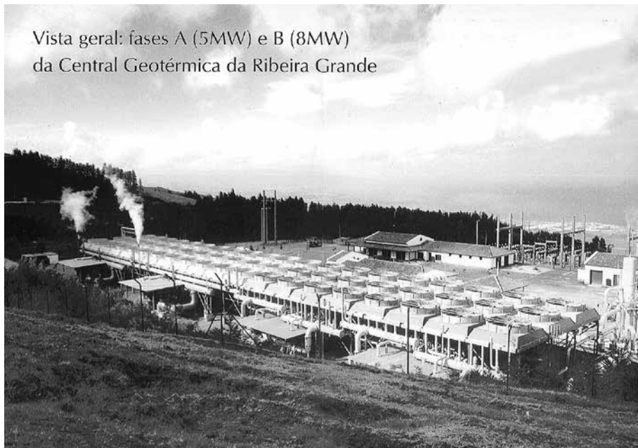
Fig. 7 – Vista geral da segunda Central Geotérmica (binária) da Ribeira Grande
